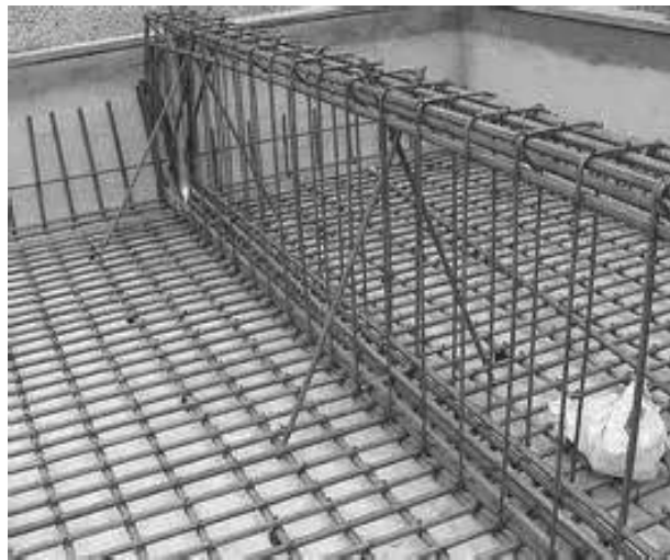
图1 钢筋结构施工
